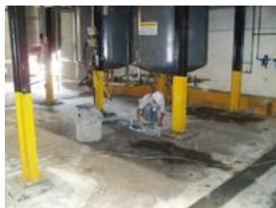
➡ Área sendo tratada as bases dos tanques.
