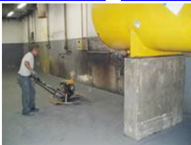
➡ Aplicação do Espatulado com acabadora de superfície
