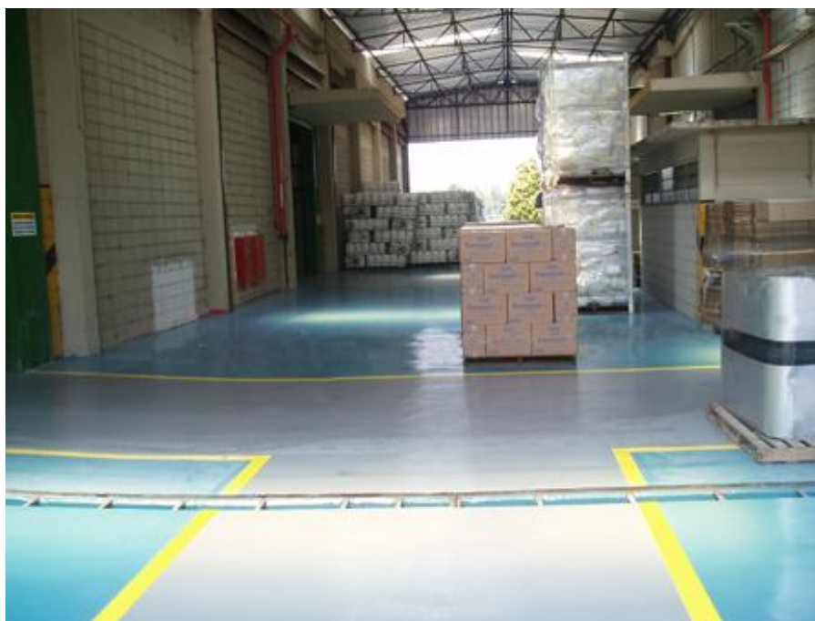
➡ Área de estocagem com revestimento Espatulado Epoxi
